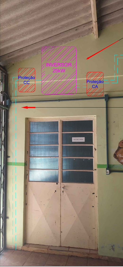
Local para instalação do inversor
